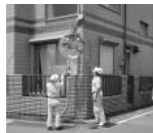
カーブミラーの清掃の様子
