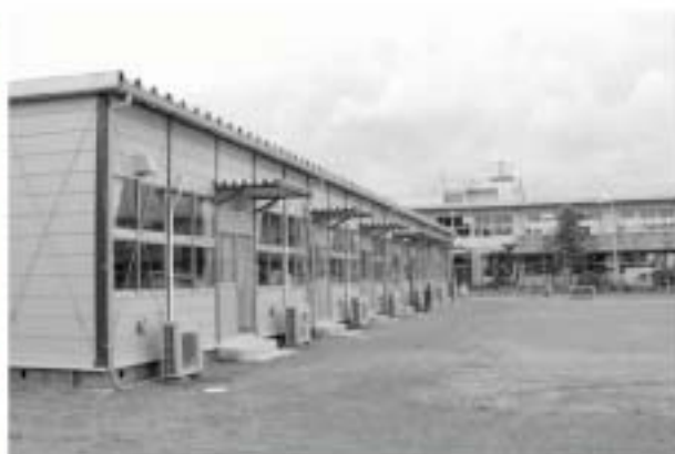
グラウンドに仮設校舎を設置(東浪見小学校)
