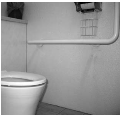
安全な手すりも設置
