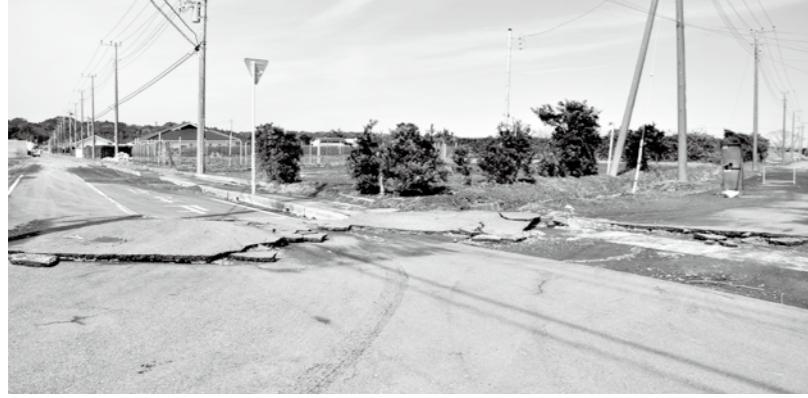
大村住宅付近交差点のアスファルト損壊
