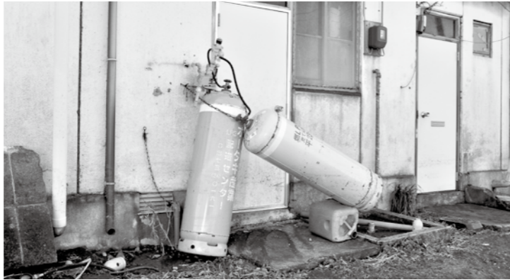
床上浸水被害を受けた大村住宅
