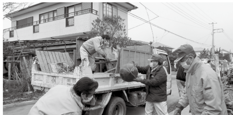
被災者宅の家財道具運搬作業
