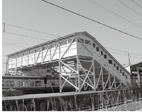
エレベータが設置されるホーム跨線橋
