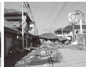
② 丸ごと道路に押し流された家屋(平成23年3月13日)
