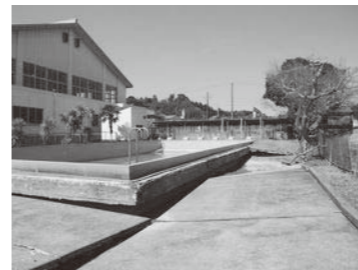
③ 液状化現象で壊れた中学校のプール(平成23年3月19日)
