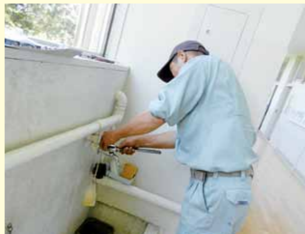
▲節水コマの取り付け作業
