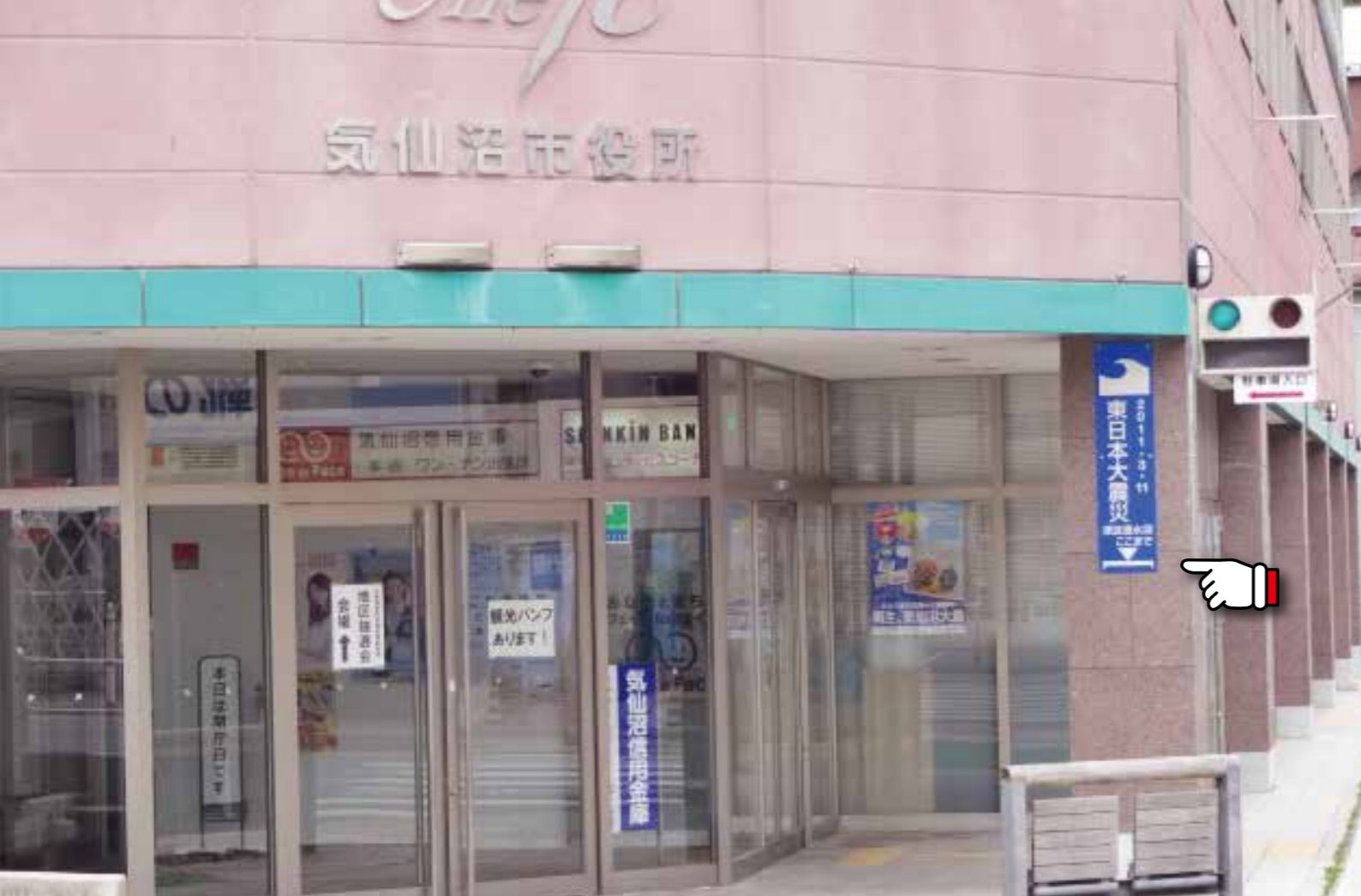
▲気仙沼市役所1階も津波により浸水しました。（右の青い看板まで）
