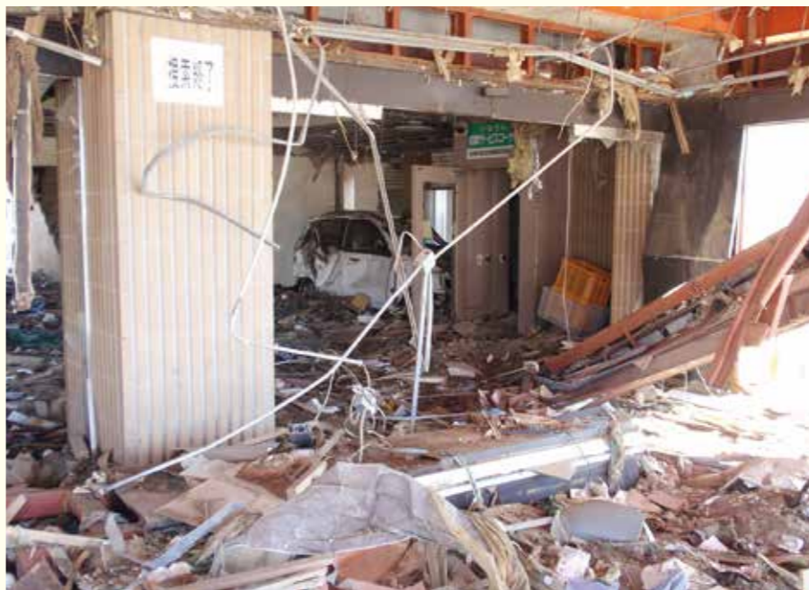
▲ 陸前高田市役所の被災状況
