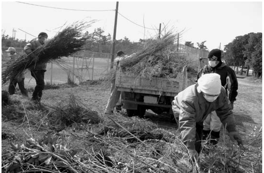
津波被災の片付けをする町職員
