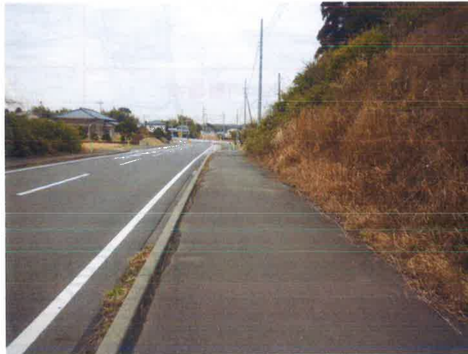
一部供用済み箇所
