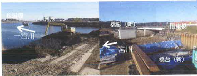
松瀨堰上流の堆積土砂撤去の状況 (令和4年12月撮影)
