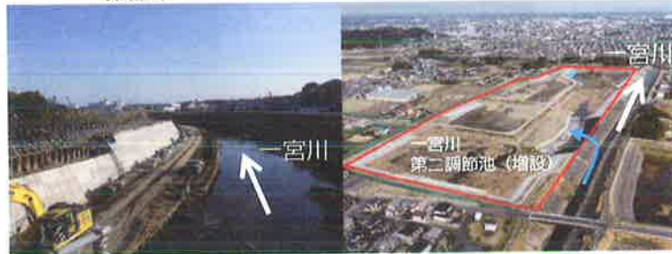
茂原市街地の護岸法立て工事の状況 (令和5年3月撮影)
