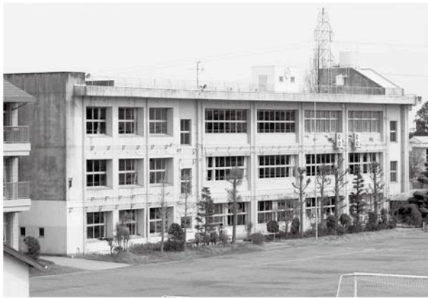
屋上防水事業が行われる 一宮中学校の普通教室棟
