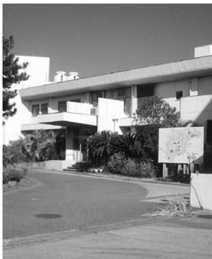
老朽化により取り壊される一宮荘
