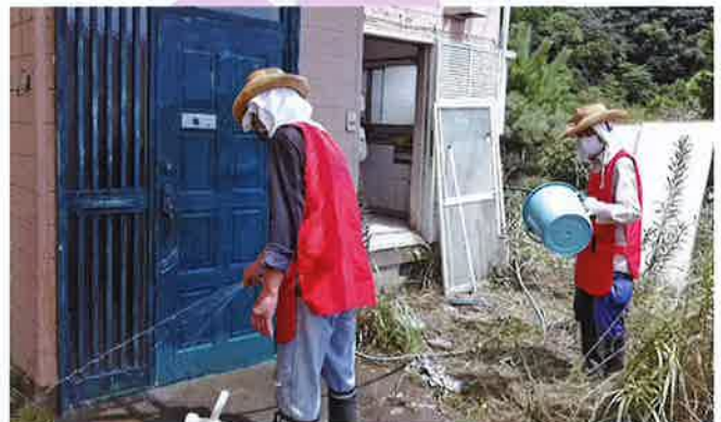
令和3年台風10号で住宅被害を受け、要請のあったお宅で泥水除去などの災害支援を行いました。(いすみ市)
