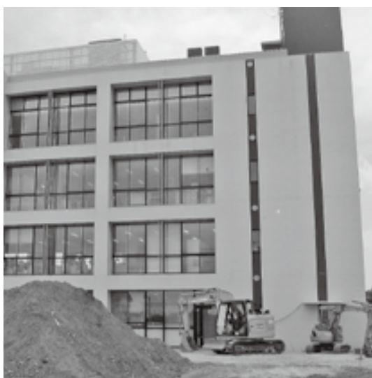
外構工事の進む役場庁舎
