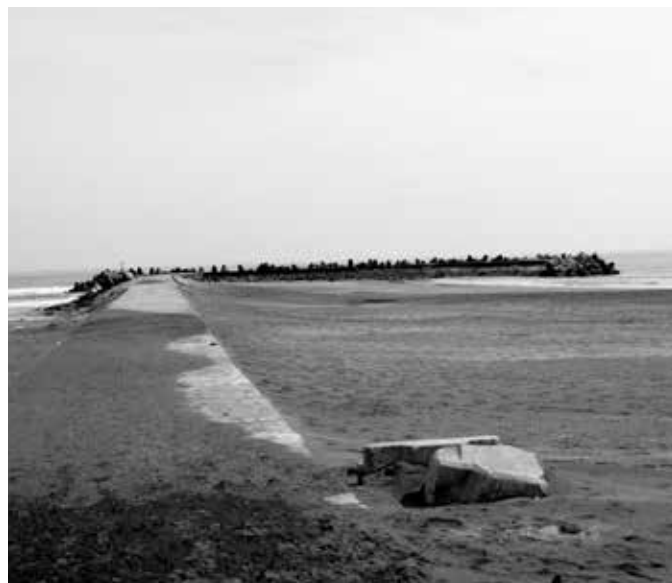
海岸に設置されている突堤（ヘッドランド）
