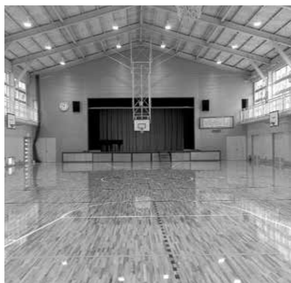
耐震改修が終わりきれいになった一宮小体育館
