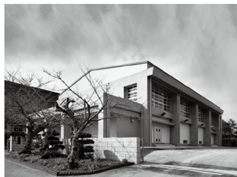
完成した一宮中学校体育館(外観)
