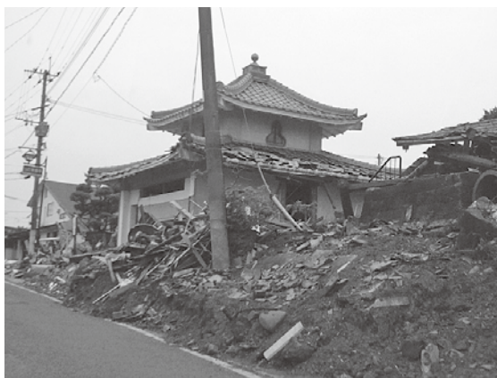
▲ 4月の熊本地震で倒壊した家（益城町）
