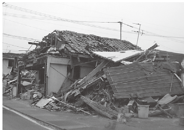
▲ 4月の熊本地震で倒壊した家（益城町）
