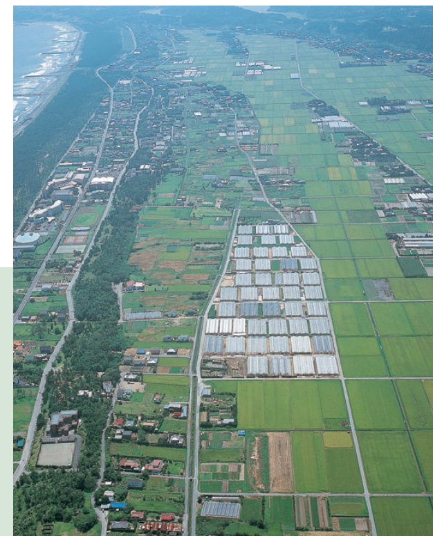
省エネルギーガラス温室団地
